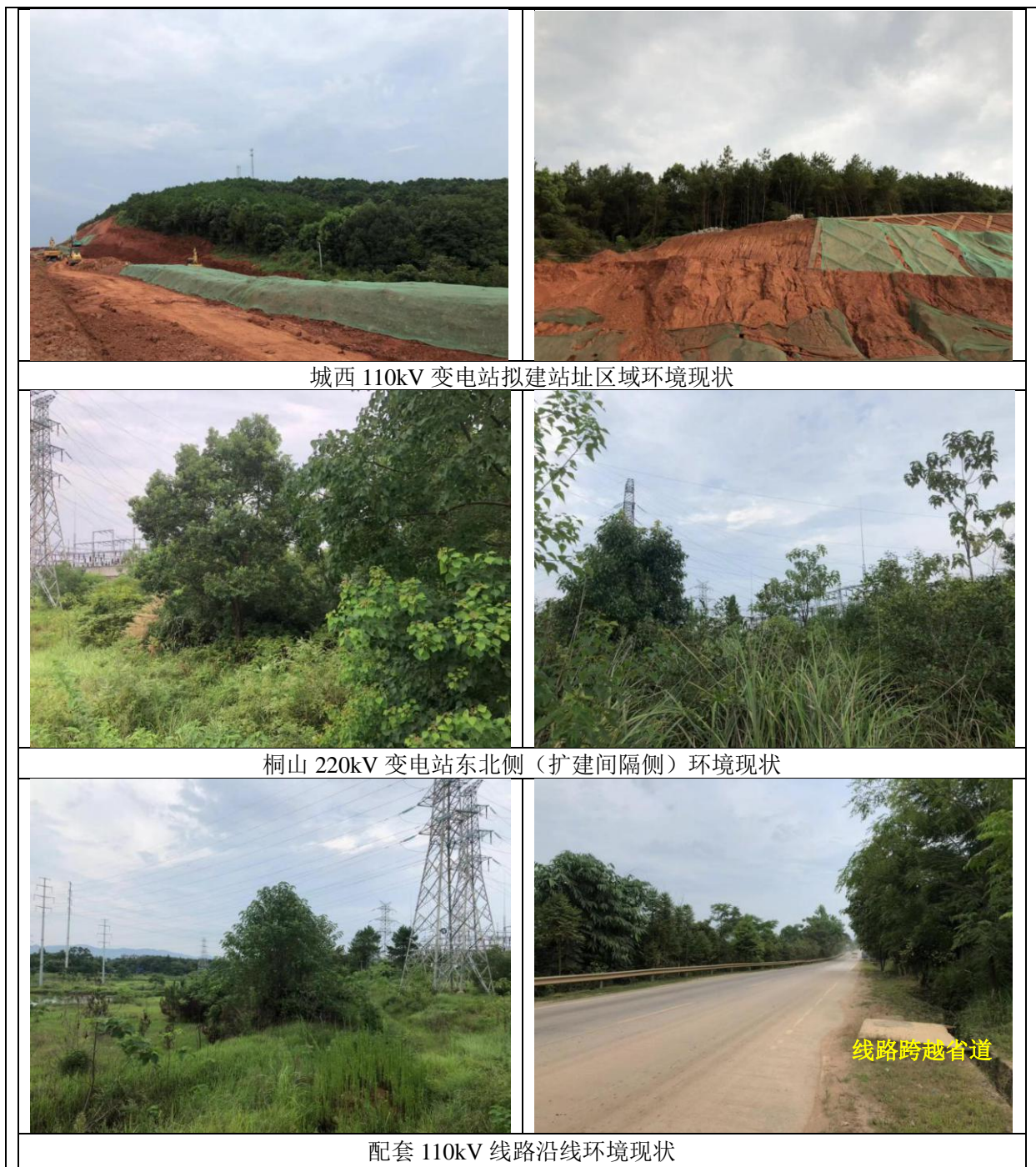
图 3-1 湖南永州宁远城西 110kV 输变电工程周边环境现状
