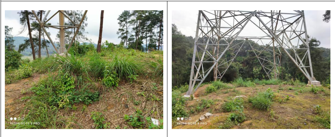
塔基区植被恢复
