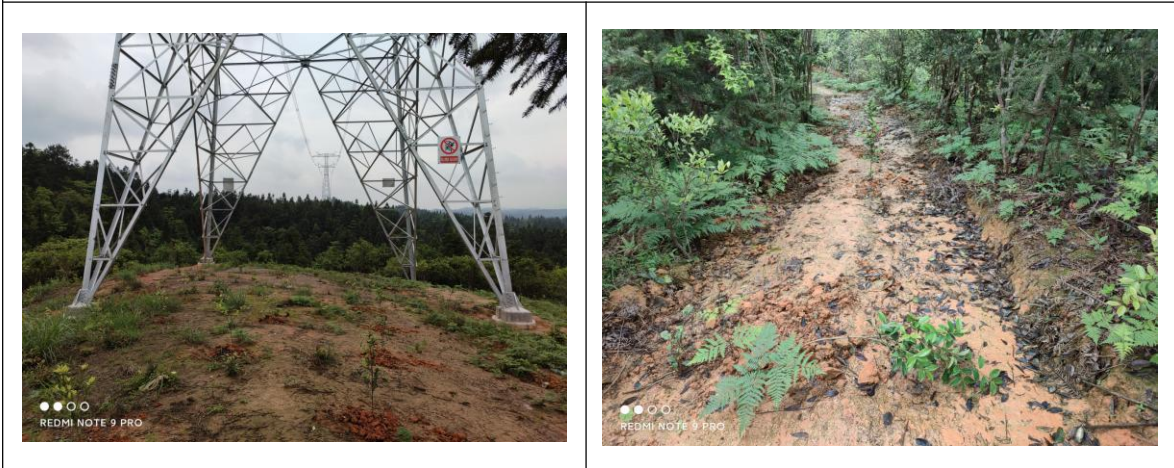
塔基区及施工道路区土地整治、撒播草籽、栽植灌木
